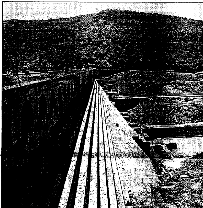
Presa de Yesa
